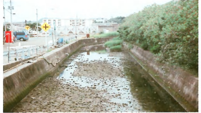
放流開始から2年経過 汚泥が500トン減ったと推計され、石ころが露出しているのが分る。
